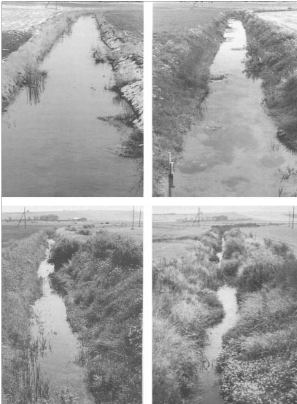
Fig. 8. Col metodo dello sfalcio mirato è possibile ricreare un canale di corrente. Le foto mostrano i risultati conseguiti tra il 1987 (in alto a sinistra) e il 1990 (in basso a destra) nel fosso Skiveren (Danimarca).
