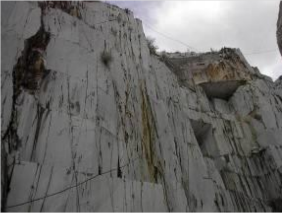
Fratture nel marmo (vie d'infiltrazione acque)
