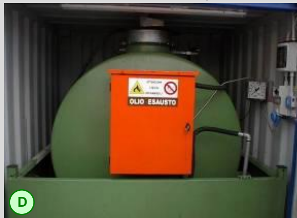
Serbatoio oli esausti in vasca di contenimento perdite
