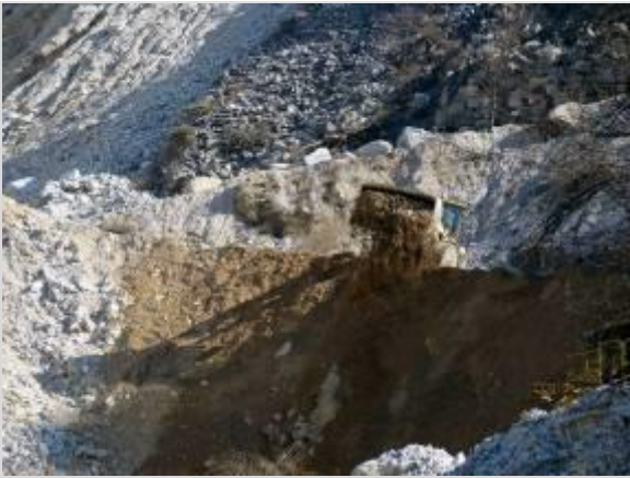
Pescina-Crestola, scarico terre
