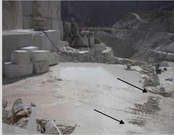
Fanghi di marmettola si disperdono dal cordolo aperto (frecce)
