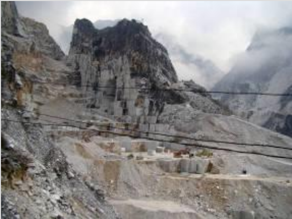
Terre in Cava Facciata (Torano-Lorano)
