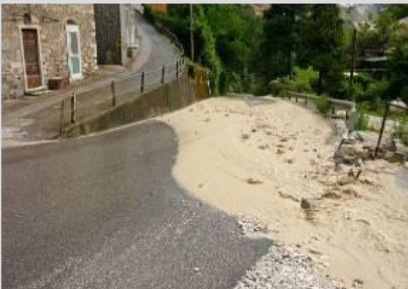
Acque fangose invadono la strada dei Canaloni (Colonnata)
