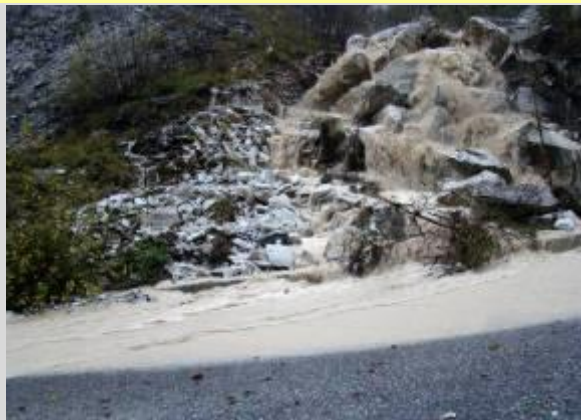
Acque cariche di terre si riversano sulla strada dei Canaloni
