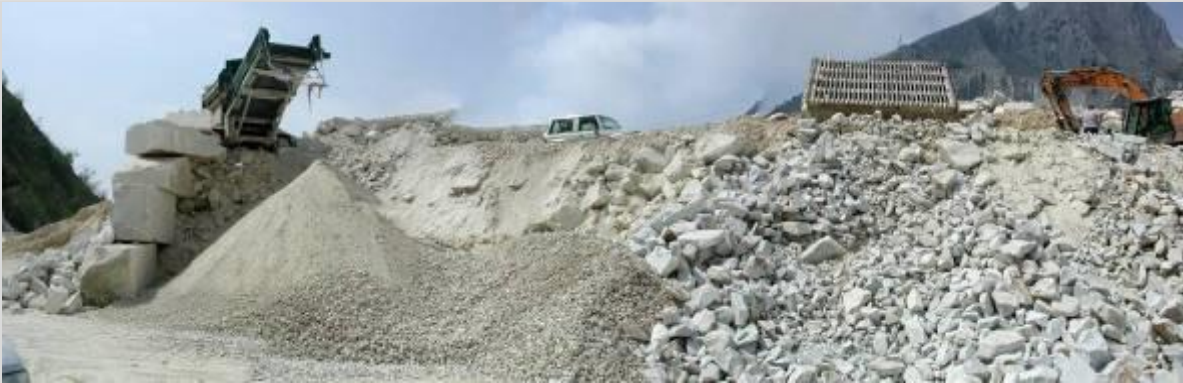
Vagliatura di detriti e cumulo di terra all'aperto (Canalgrande)
